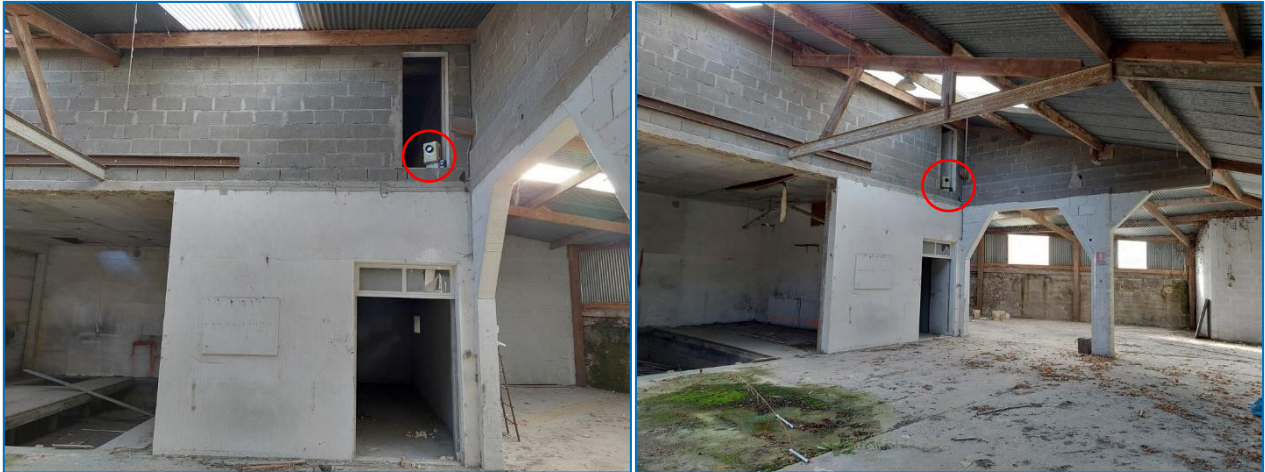
Figure 4 : Localisation de l'enregistreur à ultrasons et du piège photos dans le bâtiment 1
